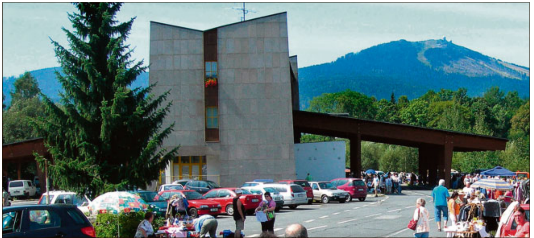
Im ehemaligen Zollgebäude von Železná Ruda soll ein tschechisch-deutsches Kulturzentrum entstehen.
